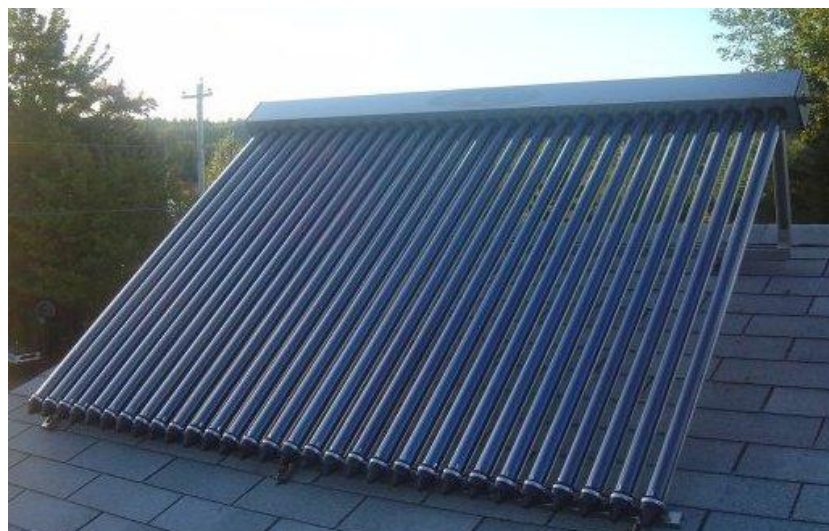
Figura 4 - Aplicação de aquecedor solar de tubo a vácuo
